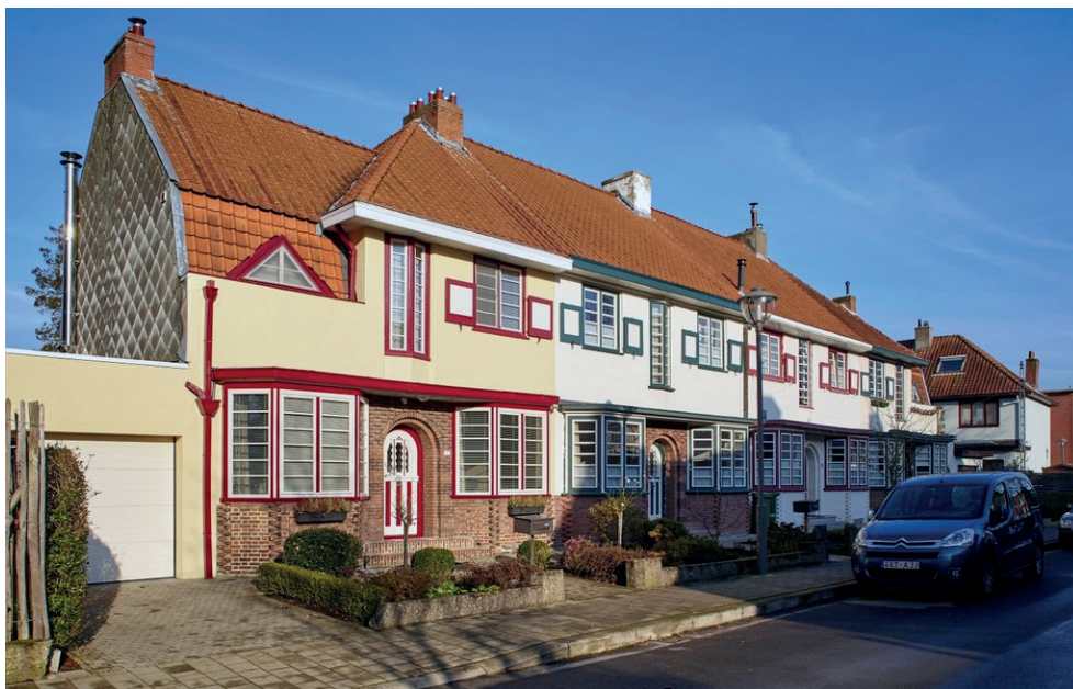
De Unitas Tuinwijk in Deurne naar het ontwerp van architect Eduard Van Steenberghe. De tuinwijk was gestart als een huurderscoöperatie, maar werd later omgevormd tot een koperscoöperatief. Tussen 1926 en 1932 werden 195 woningen gebouwd. © Onroerend Erfgoed, Kris Vandevorst
