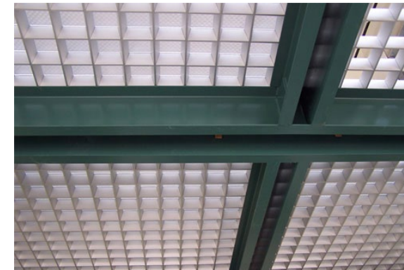
Vloer in glasdallen
