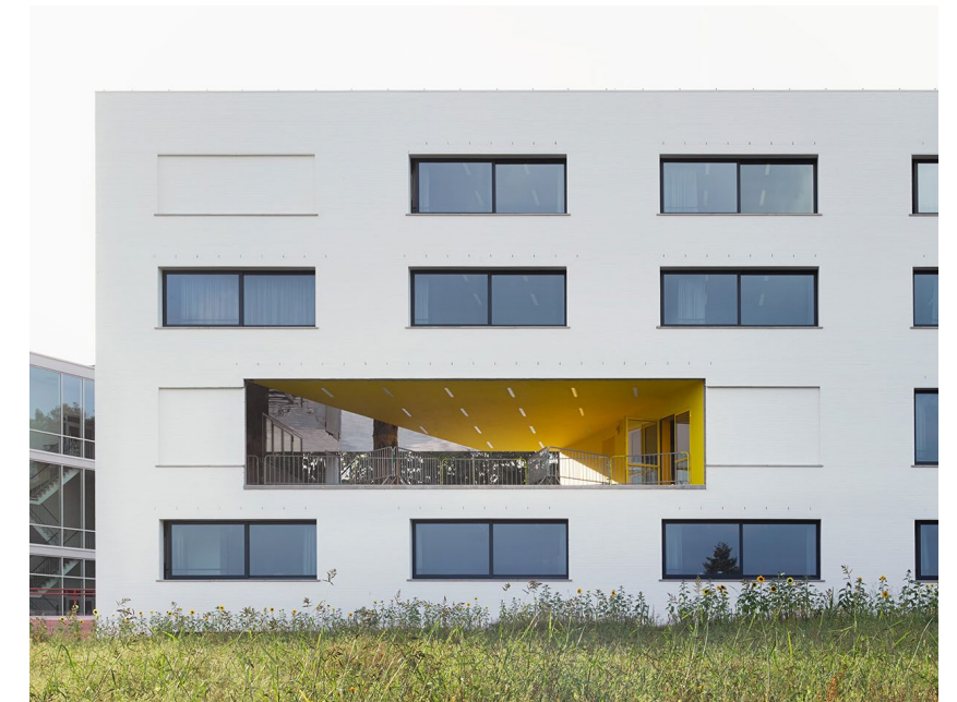
Referentie: inkom met kolom Richard Venlet, in project OFFICE 90: School de Wijnpers
