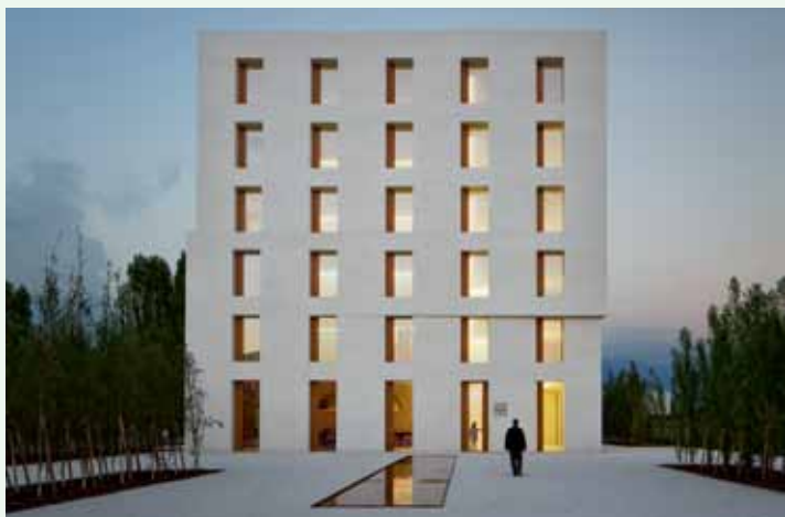
Bureaux 2226, Lustenau, Baumschlager Eberle Architekten © Eduard Hueber
