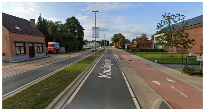
kwalitatieve fietsinfrastructuur: fietssnelweg aan kolenspoor ter hoogte van be-MINE, hoofdroute langs Koolmijnlaan tussen Beringen en Beringen Mijn
