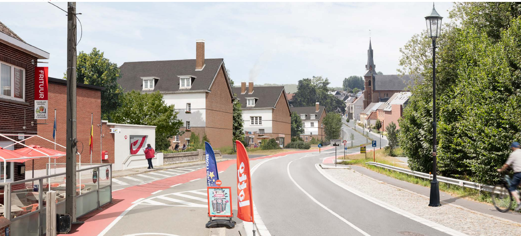
TRANSFORMATIEF TRACÉ: SINT-LAMBRECHTS-HERK, STEENWEG — Hoe snel mag ik hier rijden? Ik kronkel rechtdoor. Een lantaarnpaal als poortwachter. Brood voor morgenvroeg. Timmer de straatzijde dicht! Tussen twee gevels begint een waslijn zwaar te worden. De Lottovlag staat buiten. Zone 50. © Michiel Deumens, Tobias Van Hecke
