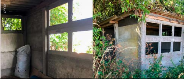
1 Betonnen kot in de velden van Boutersem, in de buurt van een snelwegparking. Een buurtbewoner riep op om het kot op te waarderen tot menswaardige schuilplaats.
