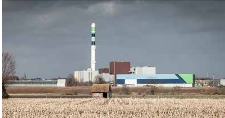
Restafval wordt omgezet tot warmte voor de nieuwe woonwijk, het warmtenet is reeds verbonden met omliggende publieke functies.
