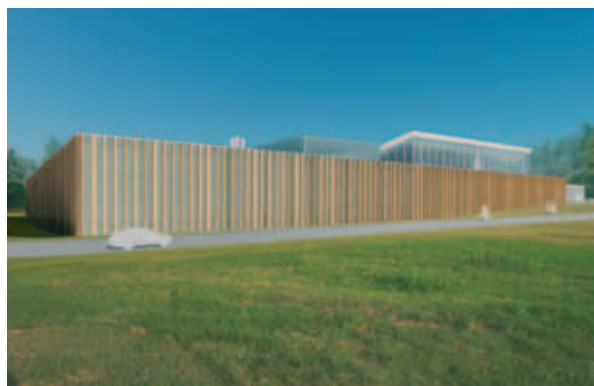
Het ontwerp van Group A bakent met één omarmende beweging de bouwsite af en zo gaat het bestaande deel uitmaken van een gloednieuw gebouw met één duidelijke toegang
