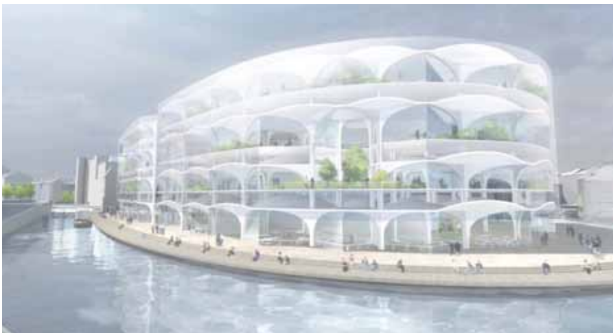
De bibliotheek van Toyo Ito is opgebouwd uit ronde cellen die in diameter verschillen en die telkens door gewelfbogen worden begrensd en ondersteund
