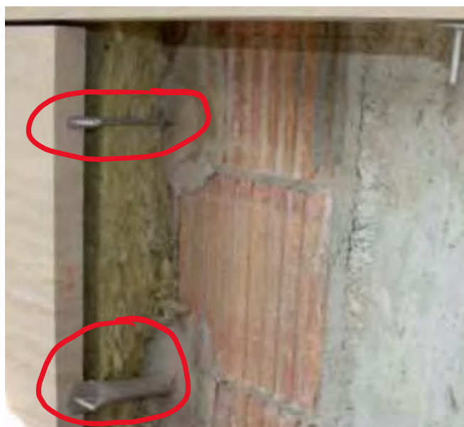
afbeelding 09 Mortelanker in rvs ter illustratie van het principe van dit systeem met zijdelingse bevestiging, beeld producent Halfen – NB: deze foto is niet afkomstig van het gebouw en de gevelopbouw is niet representatief
