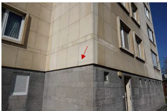
Foto 25 - Herstelling barst met kitvoeg
