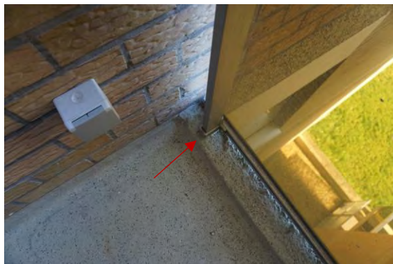
Foto 85 - Dichting over bevestiging borstwering
