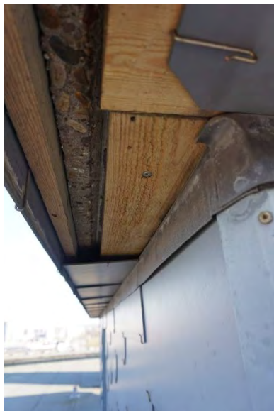
Foto 11 - Detail ingepakte betonnen oversteek volume liftmachinekamer
