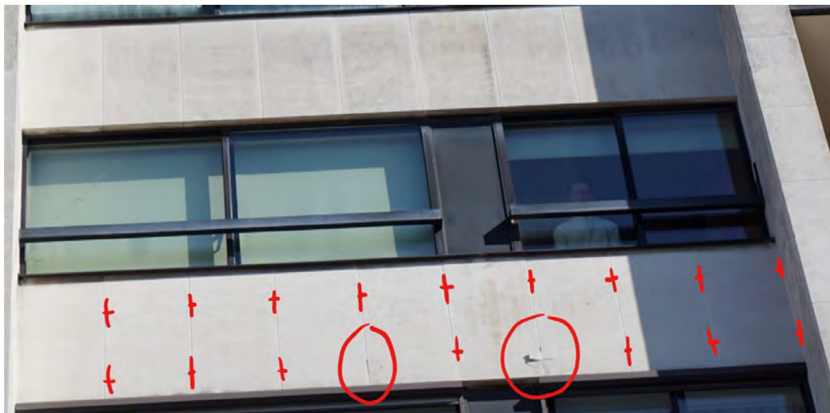
afbeelding 08 Ter illustratie: afschilferende zones wijzen op ankerpennen in de zijkant van de panelen, volgens aanduiding op de foto
