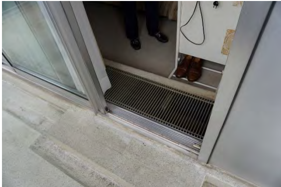
Foto 92 - Opstanden – niveauverschil naar vloerniveau binnen
