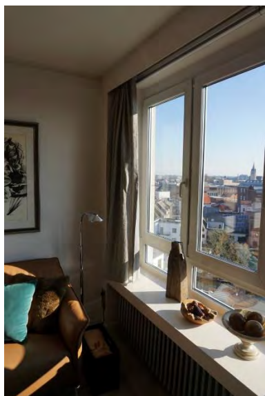
Foto 49 - Radiator in de muurdikte – app. 803
