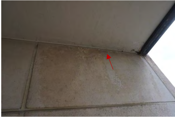
Foto 60 - Oppervlakte zandsteen in bovenhoek verweerd
