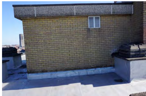
Foto 20 - Parament schilfert af en voegen lossen - ZW-georiënteerde gevel bovendakse volumes
