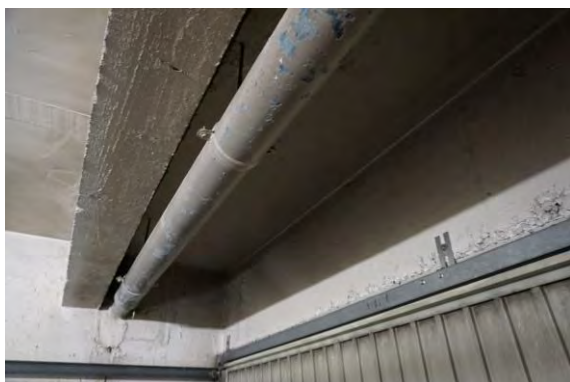
Foto 143 - Garagebox 3 – zijde voorgevel
