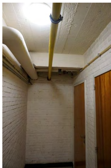
Foto 76 - Brandcompartimentering gang gelijkvloers
