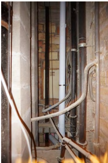
Foto 89 - Verlaagd plafond gangzone – app. 703
