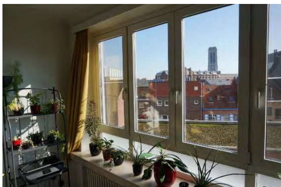
Foto 59 - Radiator in de muurdikte – app. 203
