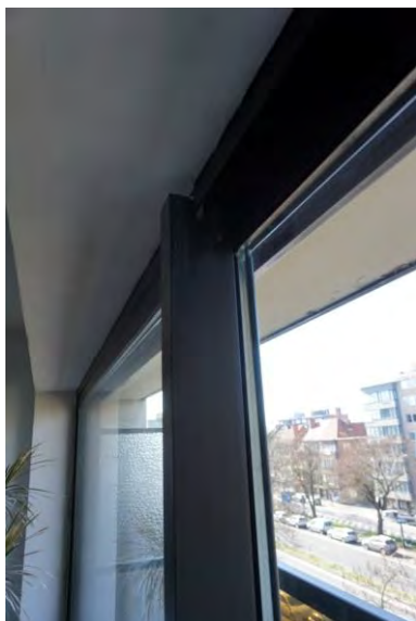
Foto 42 - Origineel niet-thermisch onderbroken schrijnwerk, met originele dubbele beglazing
