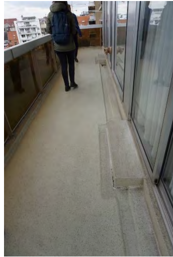
Foto 93 - Vloeibare waterdichting, gootzone
