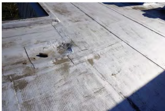
Foto 14 - Dakopstand en tappunt zijde achtergevel
