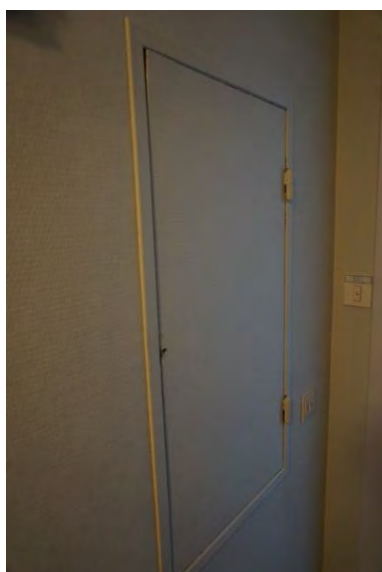
Foto 127 - Schachtdeur in gemeenschappelijke gang
