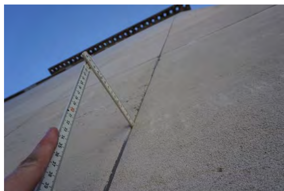
Foto 48 - Dikte paneel tot binnenspouwblad ca. 7 cm, gemeten in verticale voeg vorige foto
