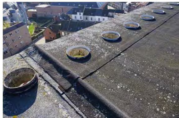
Foto 04 - Aansluiting kroonlijst met burelen Oliveten I (Olivetenvest 39) – NB buizen bij burelen verwijderd
