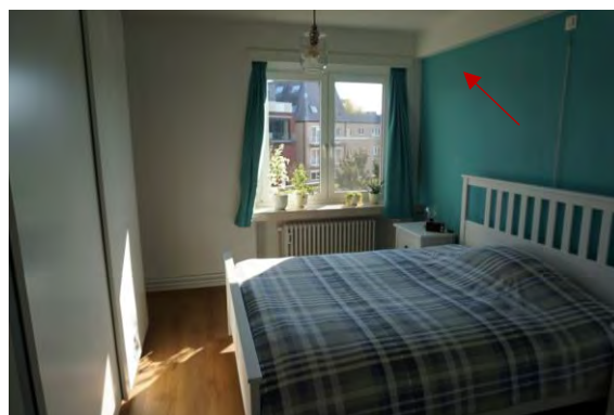
Foto 52 - Structurele balk betonskelet zichtbaar in binnenafwerking – app. 803
