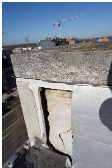
Foto 07 - Stuk zandsteen ontbreekt boven opstand
