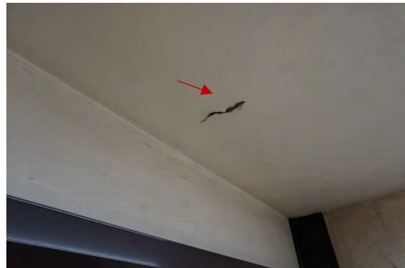
Foto 71 - Schade onderzijde terrasplaat
