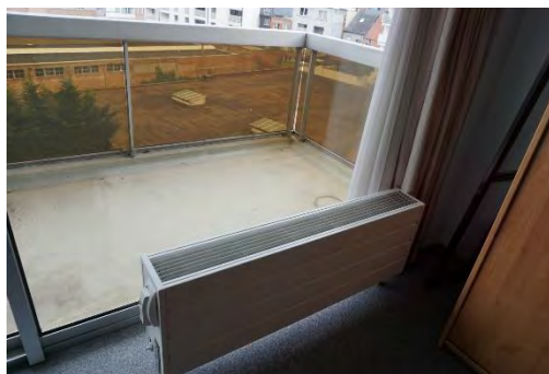
Foto 124 - Convecteur met calorimeter
