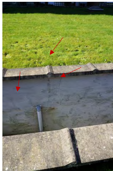
Foto 151 - Barsten in de afwerking – losse afdekstenen
