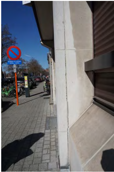
Foto 30 - Langse scheur kitvoeg
