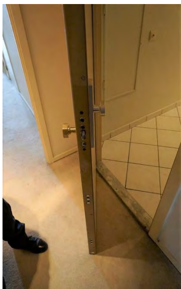
Foto 121 - Niet brandveilige veiligheidsdeur
