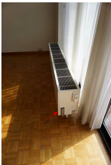
Foto 123 - Convecteur met calorimeter
