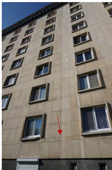
Foto 32 - Zetvoeg tussen Oliveten I en III
