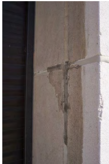
Foto 33 - Herstelling aan afschilferende hoek
