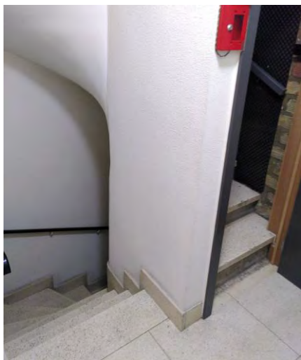
Foto 97 - Traphal geeft rechtstreeks uit op hal naar toegangsdeuren appartementen, met uitzondering van trap naar liftmachinekamer
