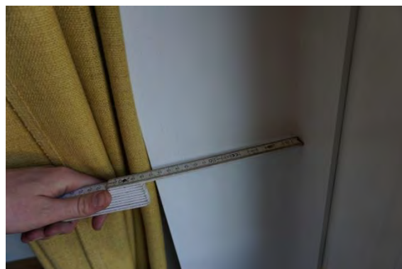
Foto 60 - Dikte binnenzijde muur 17cm – app. 203
