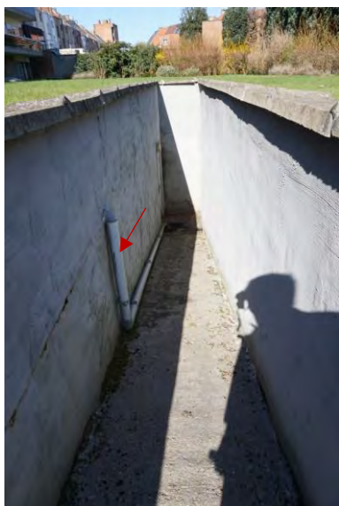
Foto 150 - Afvoerbuis drainage
