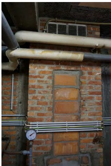
Foto 85 - Aanpassingen aan bovenverluchting sookplaats
