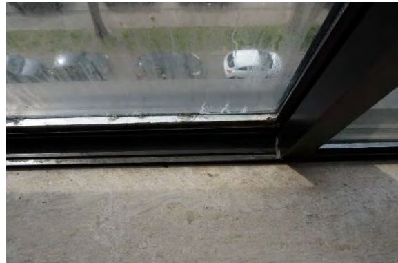
Foto 63 - Condensatie dubbel glas schuifraam
