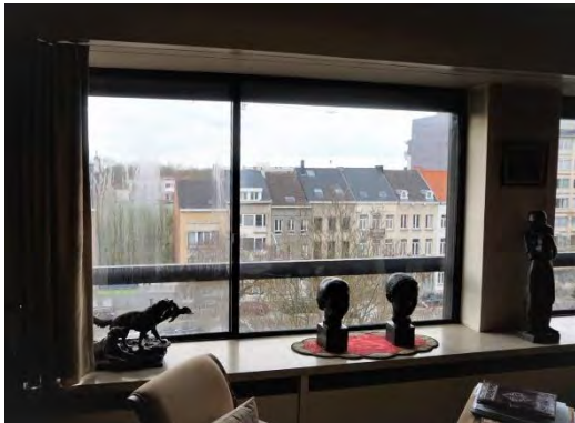
Foto 62 - Condensatie dubbel glas schuifraam
