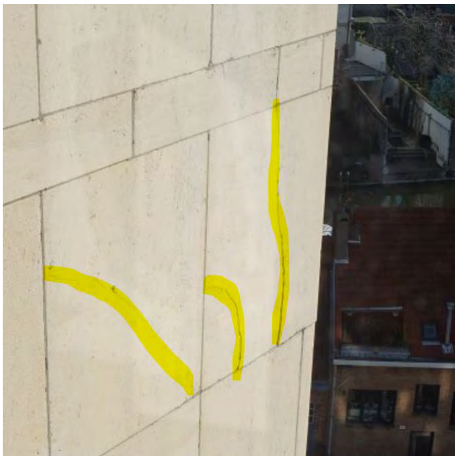
afbeelding 07 Ter illustratie: verticale en diagonale scheuren
