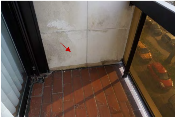
Foto 66 - Opstand bijkomende dichtingslaag / waterafstotende behandeling tegels
