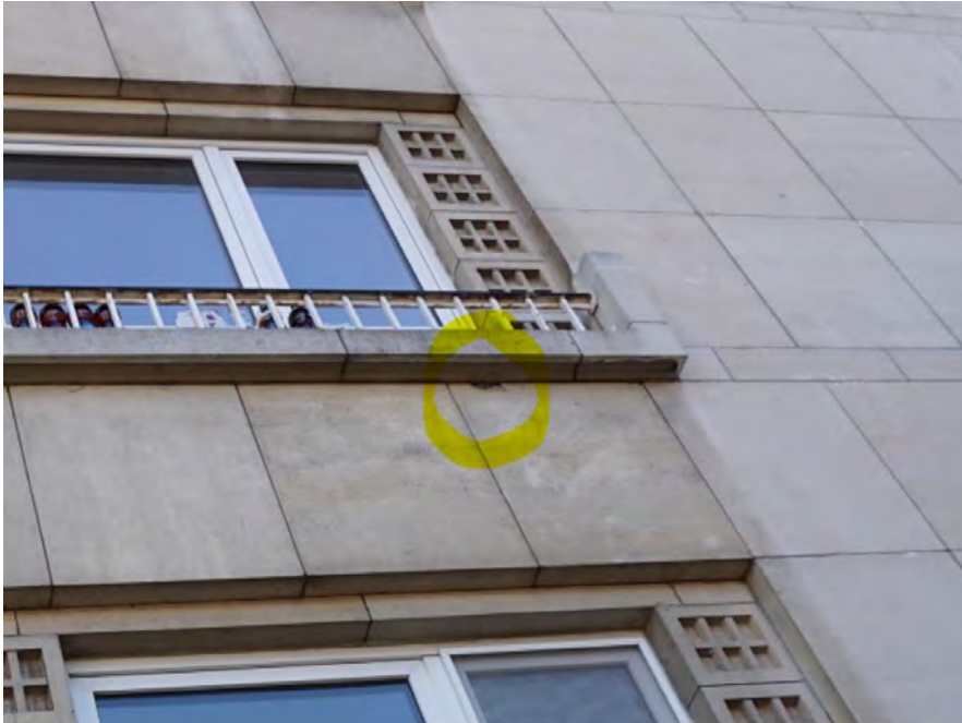
afbeelding 08 Ter illustratie: afschilferende zones wijzen op ankerpennen in de boven / onderzijde van de panelen
