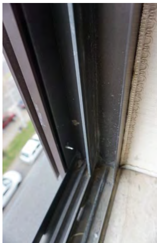
Foto 64 - Thermisch niet onderbroken aluminium raamkader
