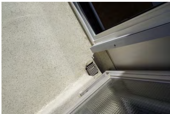
Foto 90 - Afvoer terras in vloerbare dichting
