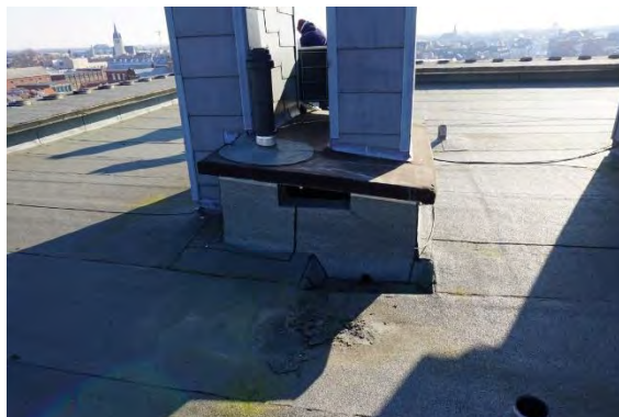
Foto 08 - Afwerking schouw boven centrale schacht
