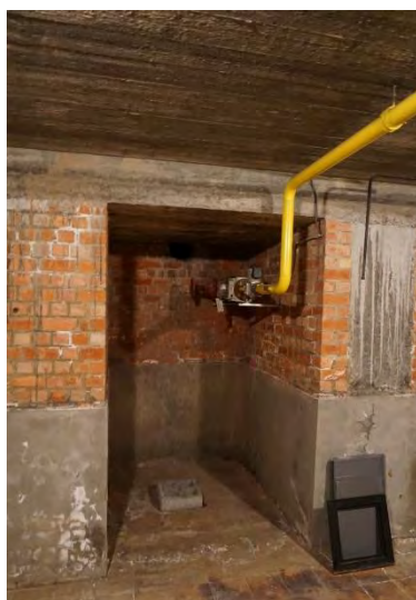
Foto 88 - Nieuwe gasleiding, getrokken na supprimeren stookolieketel
