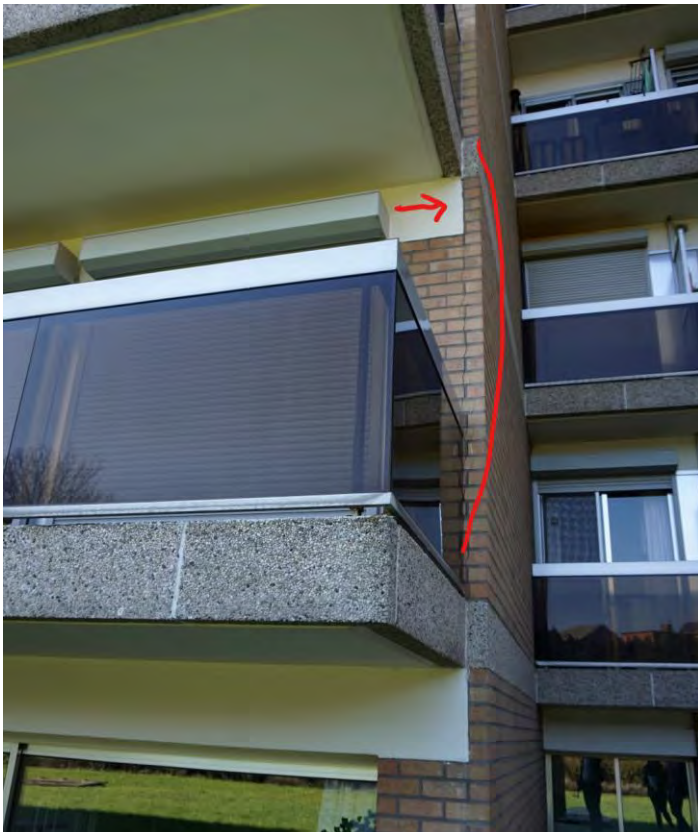
afbeelding 12 Ter illustratie: verticale scheuren door uitzetting balk boven raam naar terrassen
