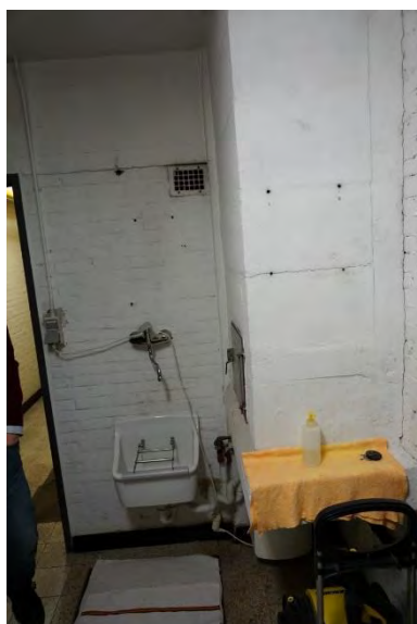
Foto 75 - Vuilschacht niet meer in gebruik
