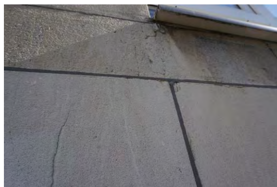
Foto 42 - Verweerd uitzicht onder dorpel, verticale / diagonale scheur
