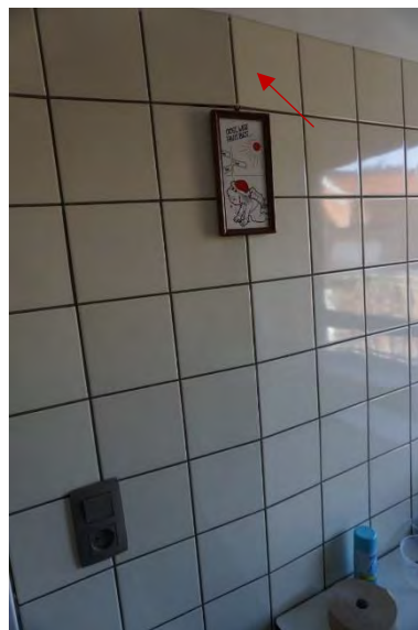
Foto 64 - Originele keukentegels die “bol” staan – mogelijke lokale zetting structuur – app. 102
