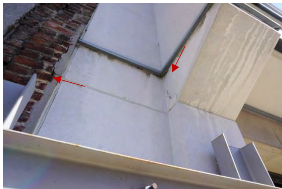
Foto 27 - Zandsteen schilfert af, kitvoeg in slechte staat
