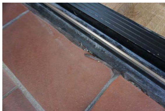
Foto 45 - Loskomende kit tussen tegels en onderregel schuifraam
