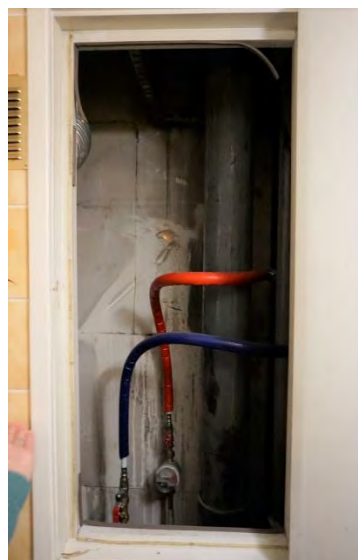
Foto 126 - - Schacht in het toilet
