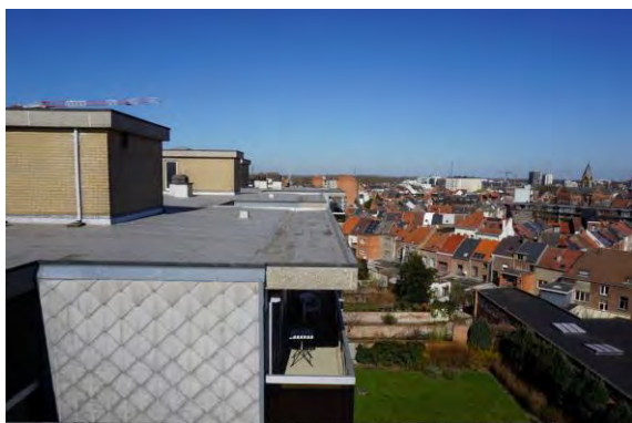
Foto 13 - Overzicht plat dak zijde achtergevel
