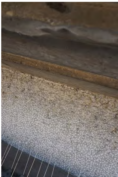
Foto 15 - Gevelaansluiting onder de kroonlijst
