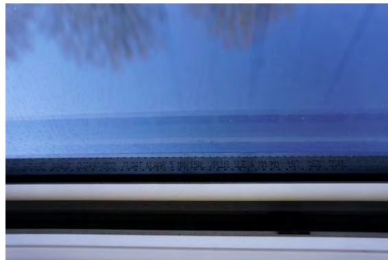
Foto 68 - Recentere dubbele beglazing in app. 001
