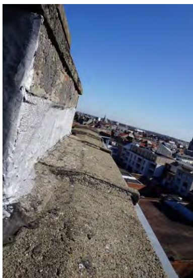
Foto 09 - Aansluiting deksteen met vloeibare dichting
