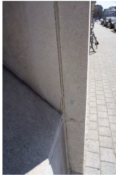
Foto 31 - Langse scheur kitvoeg
