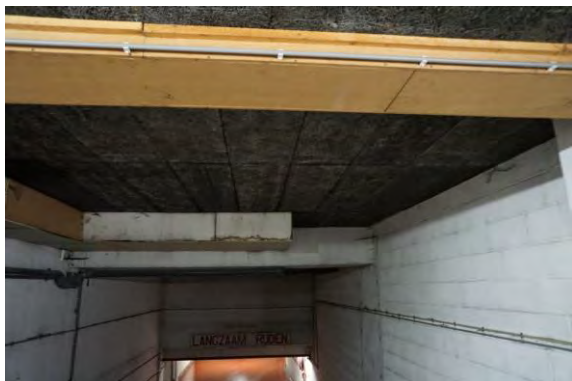
Foto 149 - Plafond parkeergarage – houtwolcementplaten dikte ca. 5 cm
