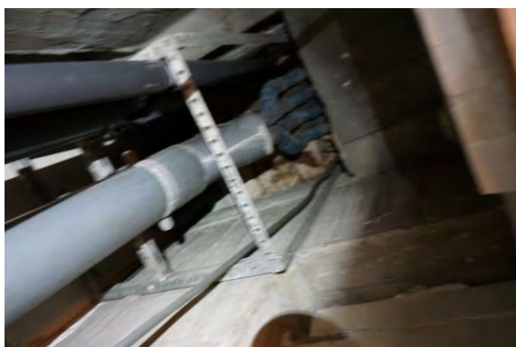
Foto 113 - Schacht toilet – invulling afvoerleidingen
