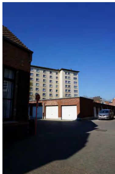
Foto 34 - Garages en achterzijde gebouw, gezien vanaf Olivetenstraat
