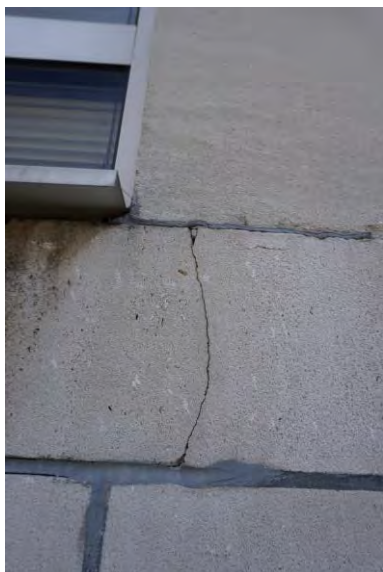
Foto 39 - Verticale scheur – natuursteen rond scheur klinkt hol
