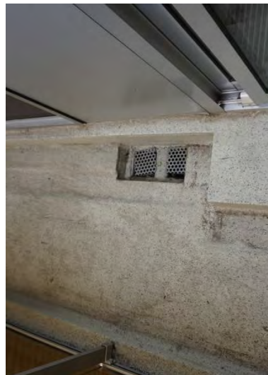
Foto 97 - Tappunten in vloeibare dichting
