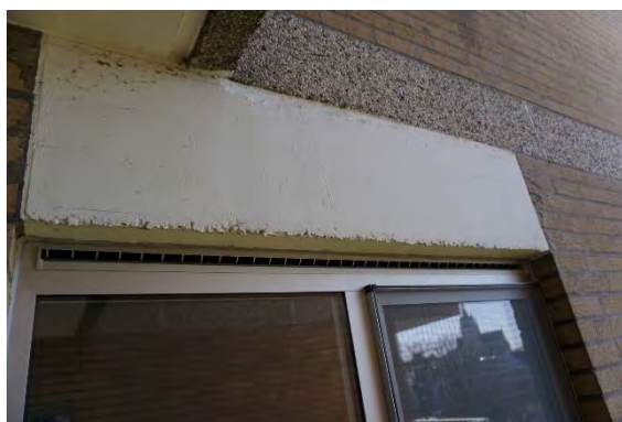
Foto 114 - Ventilatiooroster nieuw schrijnwerk
