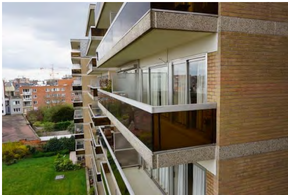
Foto 78 - Gevels inhammen metselwerk / silexbeton
