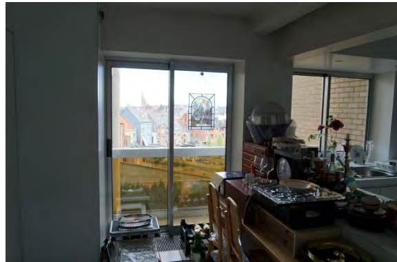
Foto 95 - Schrijnwerk achtergevel terras keuken
