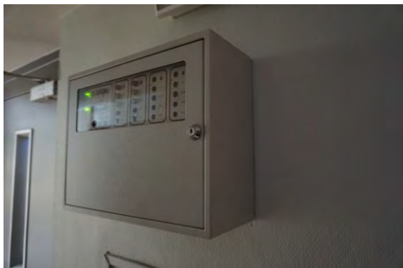
Foto 131 - Brandcentrale in hal gelijkvloers
