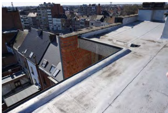
Foto 12 - Overzicht plat dak zijde achtergevel
