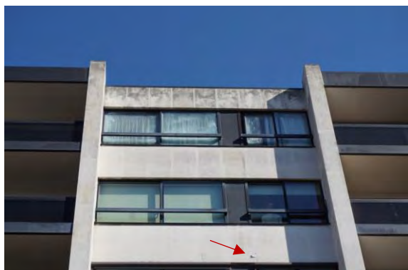
Foto 36 - Afschilferende zandsteen
