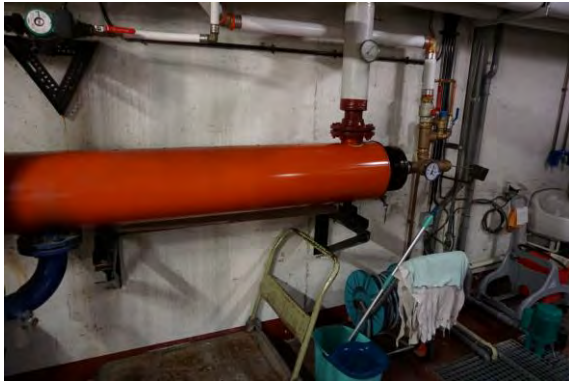
Foto 105 - Collectieve doorstroomwarmwaterboiler
