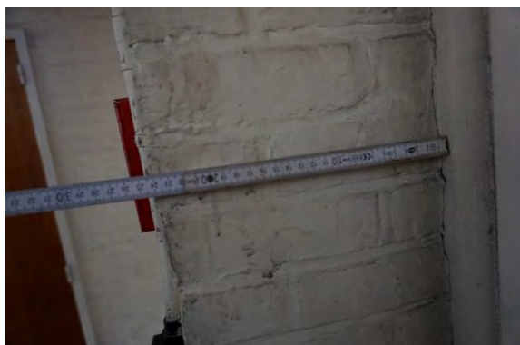
Foto 79 - Dikte muur fietsenstalling 24cm
