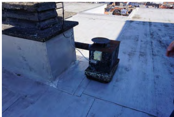
Foto 22 - Ventilatiesysteem van verdieping 5
