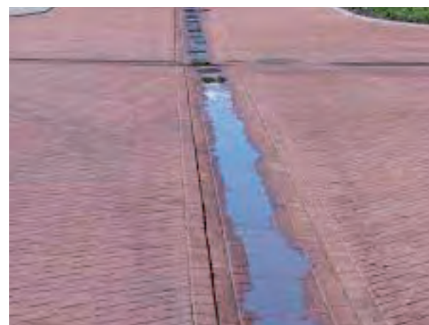
ontkoppelen HWA en regenwateropvang in de straten
