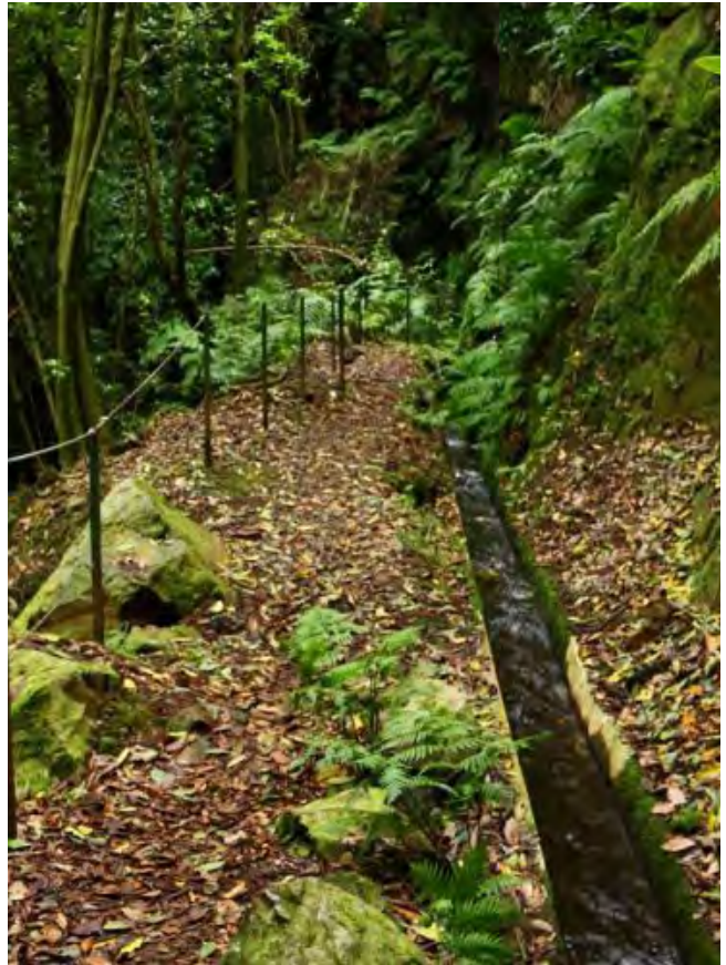
Afleidingskanaaltjes langs de flanken, Madeira
