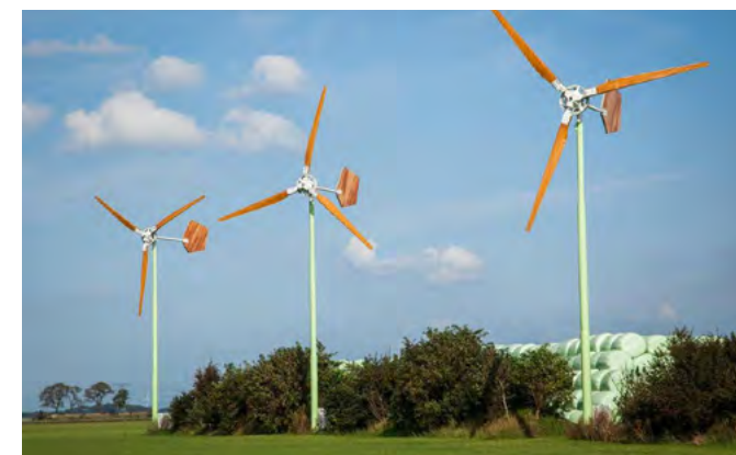
Houten windmolens in Groningen (NL). De windmolen is 15 meter hoog, heeft een levensduur van >20 jaar en voorziet ruim 9 gezinnen van stroom.
