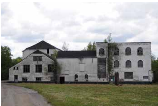
Bestaande situatie: de natuur heeft de Florival site al deels opgeslorpt. Karaktervol gebouw op Waals gedeelte van de site
