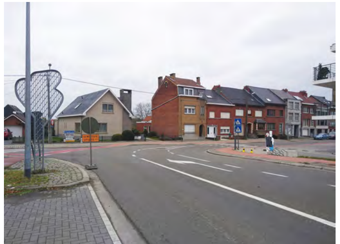
Bochtgeleiding aan kruispunt Wilgenlaan x Hoogstraat dient verkeer uit Hoogstraat (centrum Wolvertem) te weren. Door het voorzien van een linksafslagstrook richting Hoogstraat wordt sluiptegverkeer echter niet uitgesloten.
