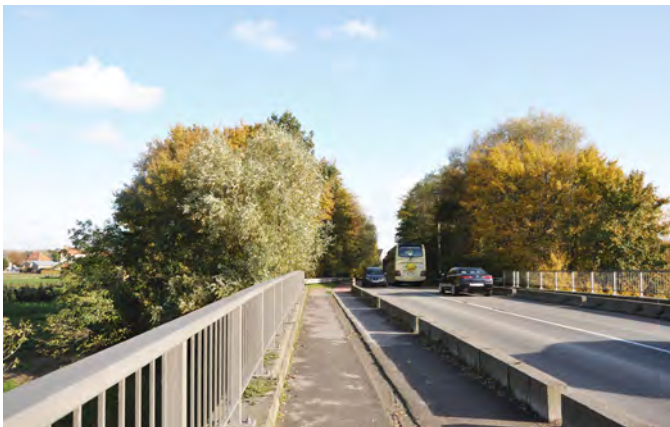
De verbindingsweg over de A12 met daarachter de kern van Wolvertem. De fietsinfrastructuur is hier niet conform het Vademecum fietsvoorzieningen.
