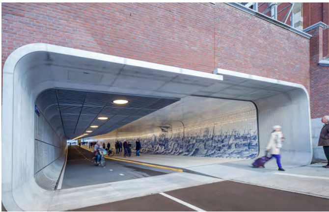
De Cuyperpassage, onder het station van Amsterdam, waar contrast duidelijk de zones tussen voetgangers en fietsers afbakt. bron: Benthem Crouwel Architects
