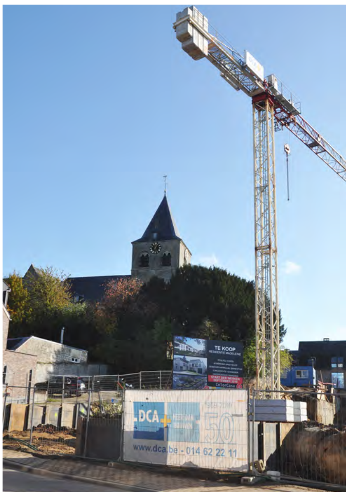
In de kern van Wolvertem wordt volop gebouwd.
