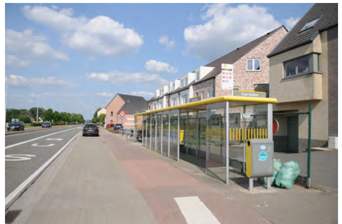
Ruime bushalte en fietsstallingen aan het vroegere station op de Haachtsebaan.
