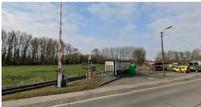
Station Vijfhuizen ligt er verloederd bij. (bron: google.be/maps )
