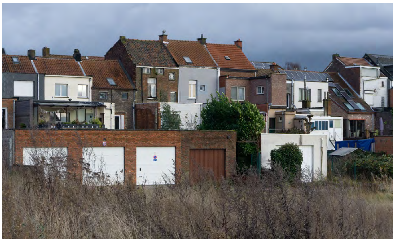
2. Woonentiteiten in Boom - achterkant naar de open ruimte toe (december 2019)
