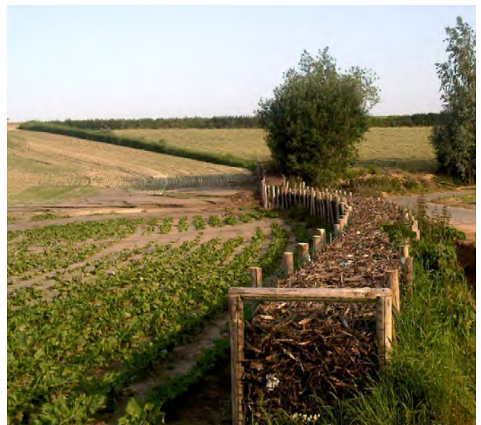
3. Een voorbeeld van een erosiedam, gemaakt van natuurlijke materialen (Provincie Limburg).
