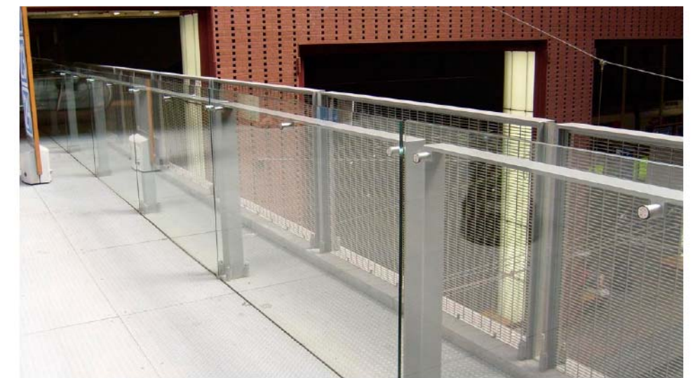
09. voorbeeld 'lage balustrade' boven hoogspanning, vernieuwd station Antwerpen
