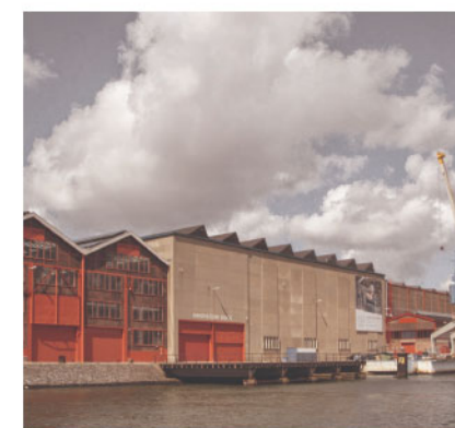
De publieke kade langsheen de onderzeebootloods van de Rotterdamse Droogdok Maatschappij.
