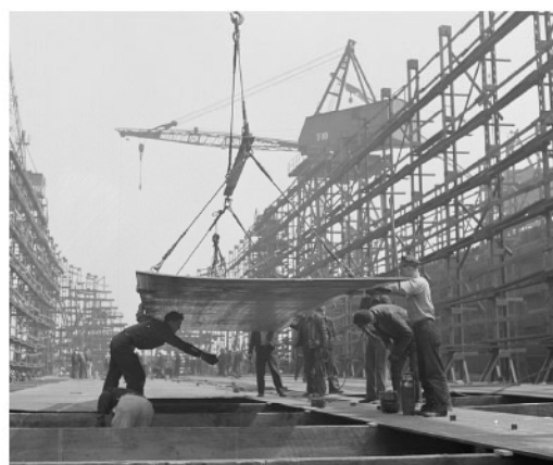
Het bouwen van een stalen romp in de Bethlehem-Fairfield scheepswerf in Baltimore.
