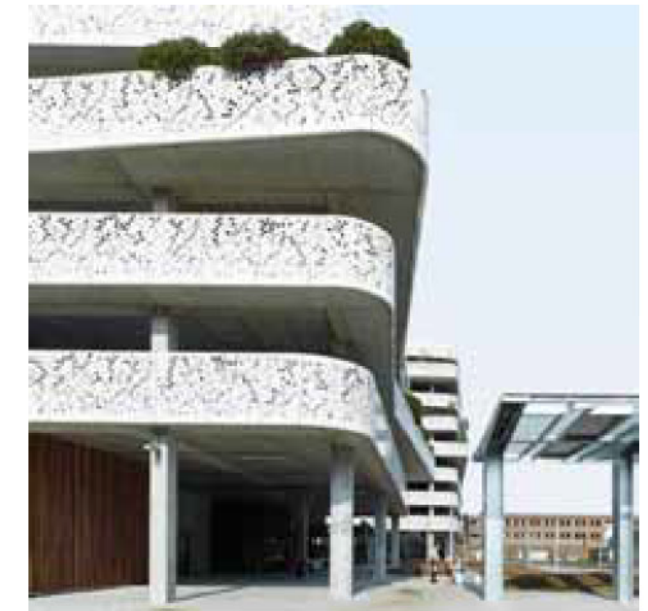
REFERENTIEBEELD Een parkeergebouw
