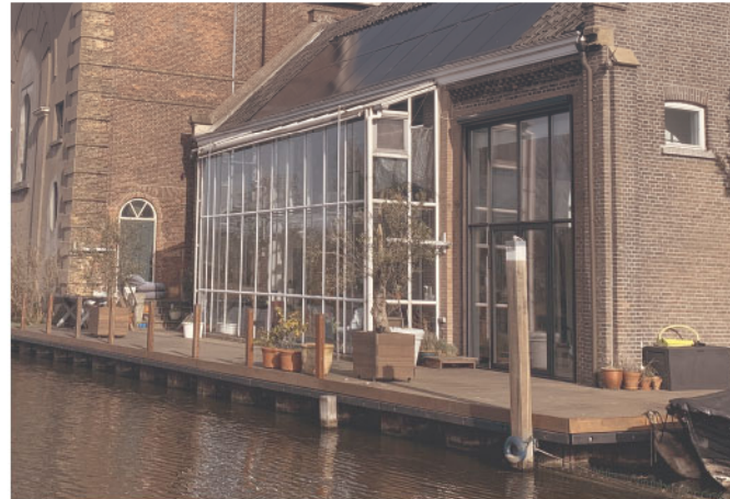
serre-achtige aanbouw herbestemde kerk Overschie (NL)
