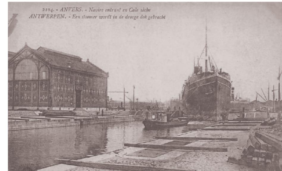
Historische foto van het pomphuis met de karakteristieke kopgevel zichtbaar.
