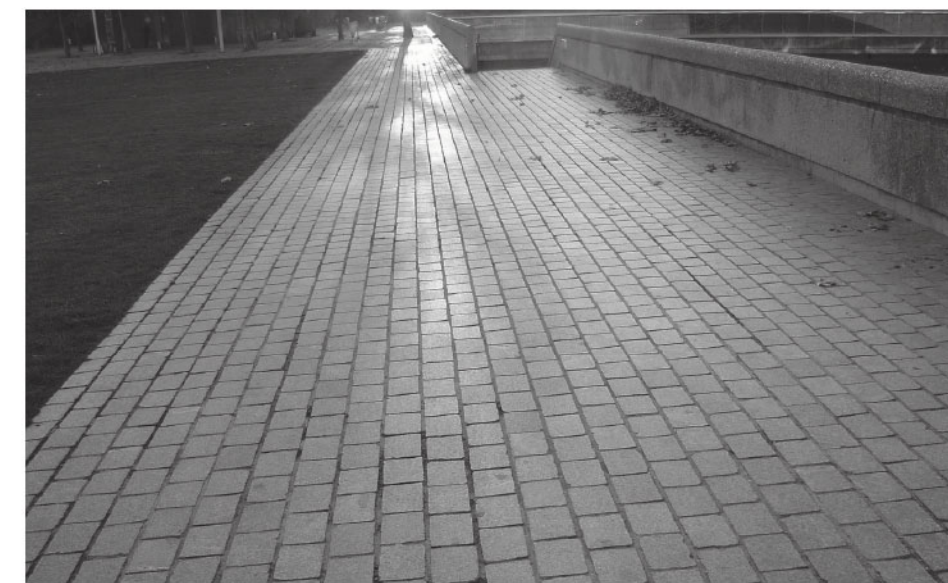
Gezaagde kasseien als comfortabele routing door het droogdokkenlandschap
