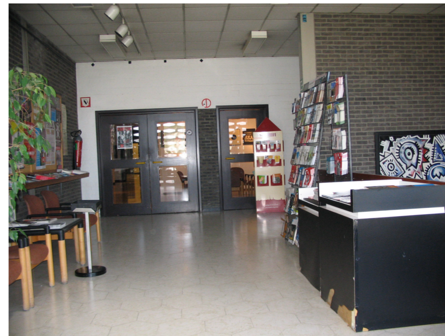
CC Luchtbal : de hoofdentree leidt direct naar de Bibliotheek; het cultuurcentrum is niet aanwezig; de balie bevindt zich op verdieping en de kleine zaal is enkel langs buiten en via de verdieping te bereiken...
