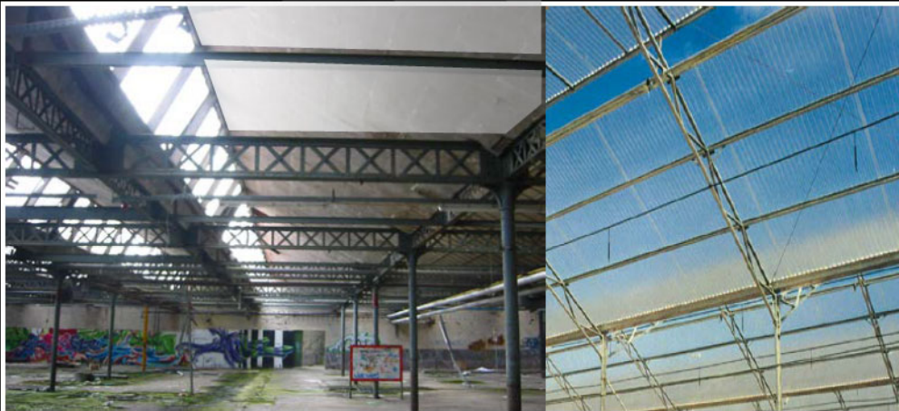
energiedak : Noorden - hoge reflectie van neutraal noorderlicht via isolerende platen, daglicht
