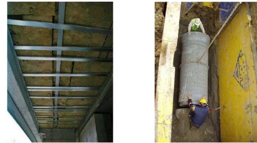
Foto 2: Werfcontrole bij de plaatsing van grond-lucht-warmtewisselaars: zeer belangrijke aspecten zijn fundering, waterdichtheid, helling.
