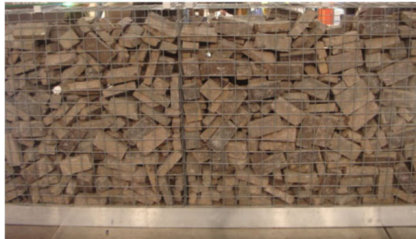
SCHANSKORVEN OPGEVULD MET BOUWAFVAL
