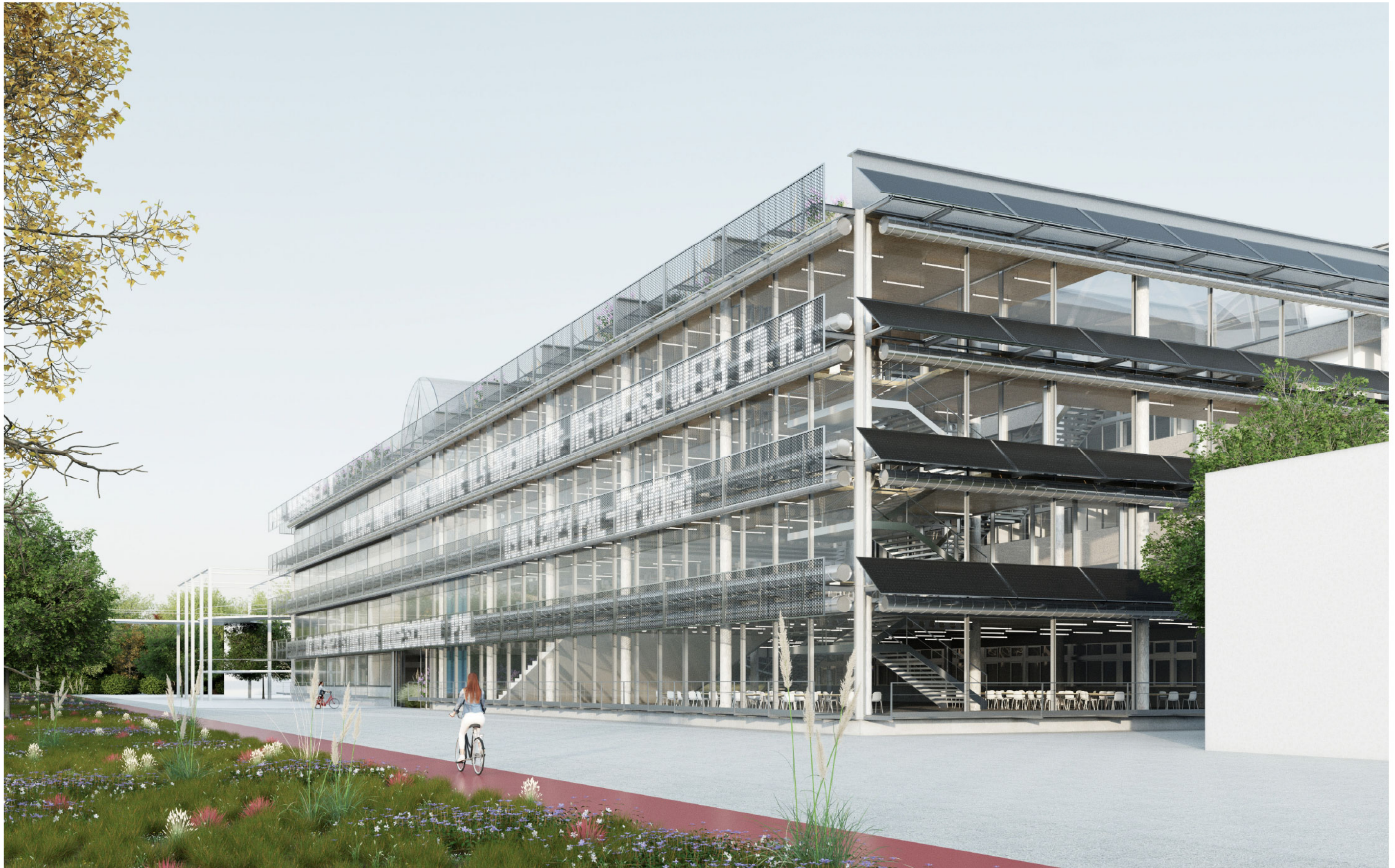
Noordfacade: zicht vanop de Singel
