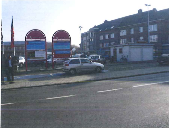
de zuidelijke gevel: A. Jeurissenstraat
