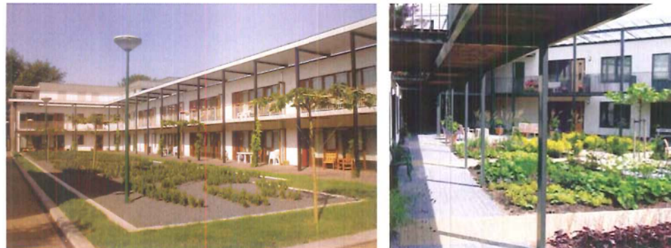
1. HANS VAN TWILLERT, SERVICE-FLATS Passerelle langs de verschillende flats.
