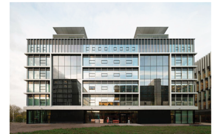
Zonneschoorstenen en venturikappen van de Erasmus Universiteit Rotterdam
