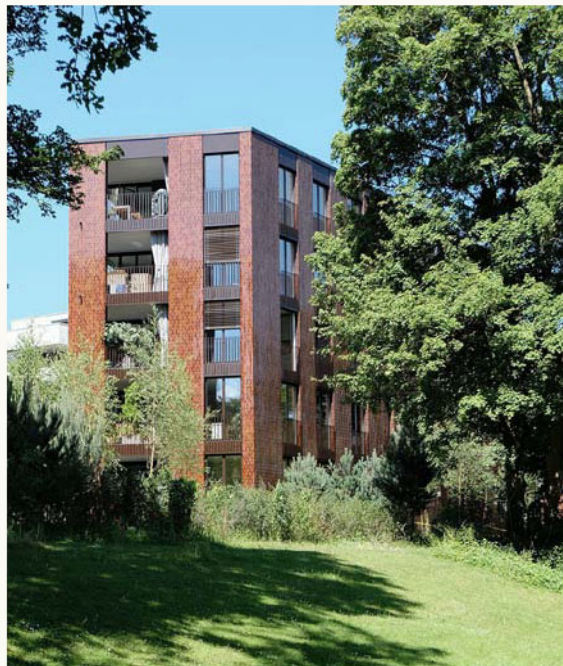
Woonproject Am Katzenbach, Zürich EMI architecten, 2015
