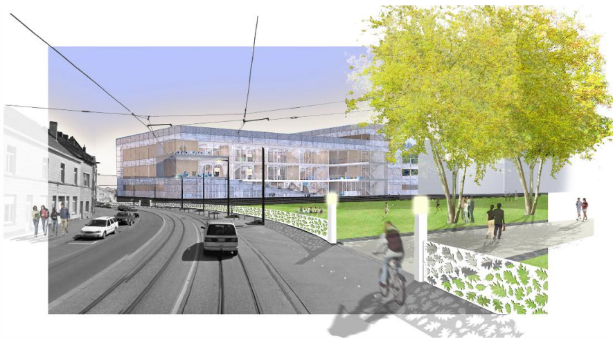
Het SOAG gebouw aan de Voskenslaan
