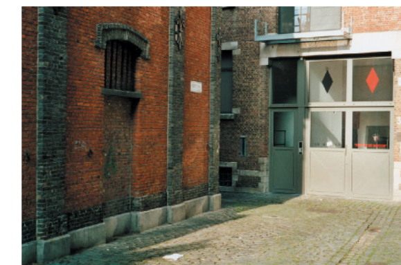
voorbeeld van een entree aan de binnenzijde van een bouwblok
