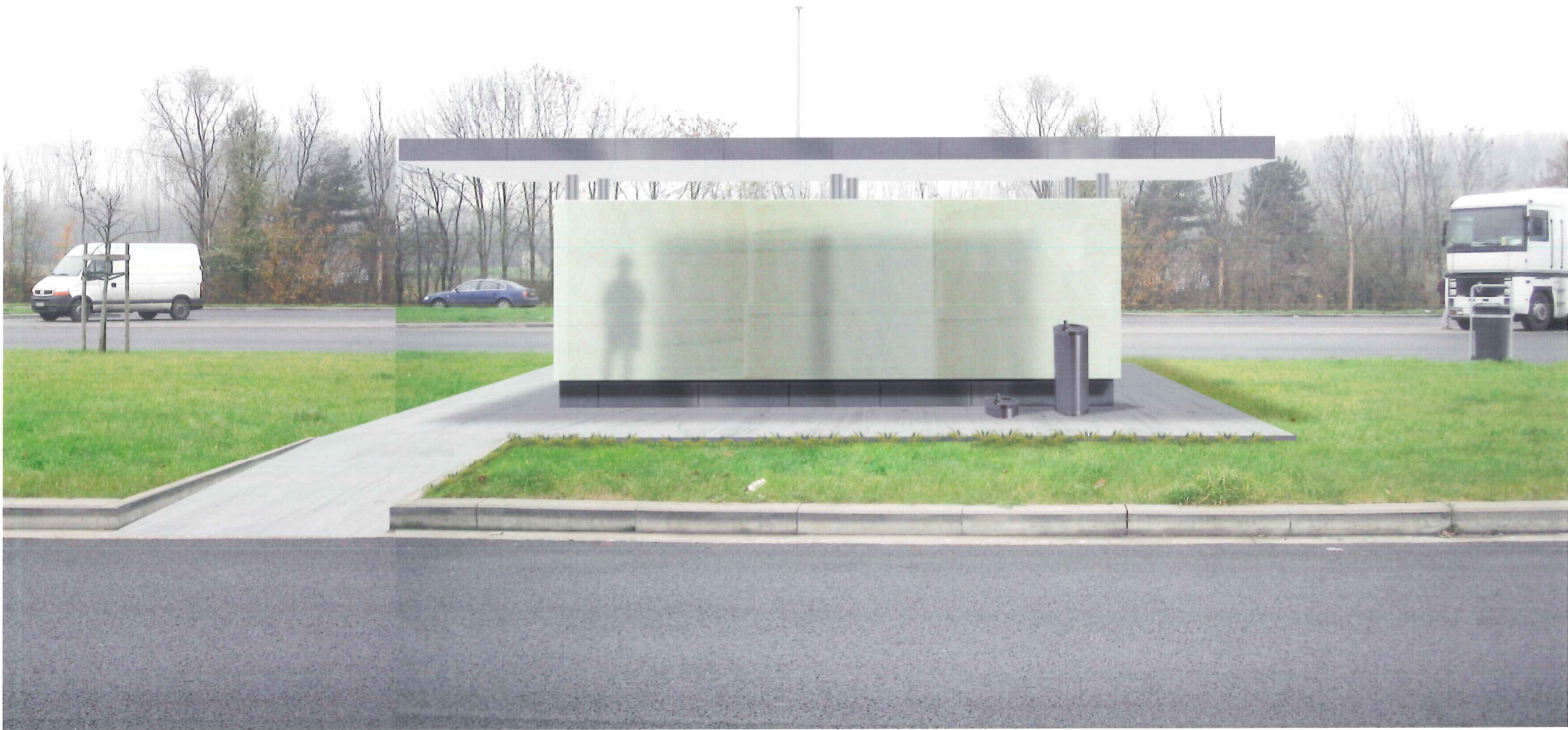
Westelijke zijde van de autosnelweg
