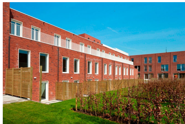
Ref. éénggezinswoningen Groen Kwartier, Antwerpen, Beel & Achtergael Architecten
