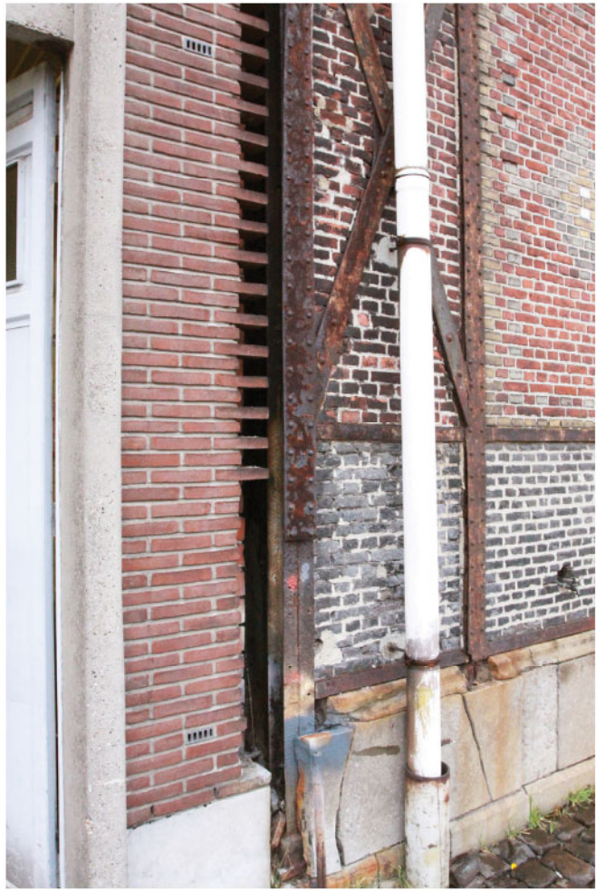
Observatie - staal en gevelmetselwerk
