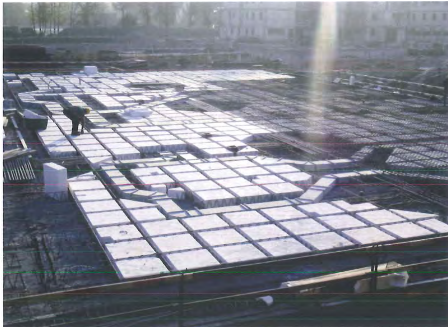
technieken zijn ingestort in de betonplaat
