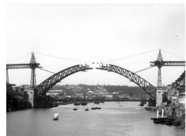
Constructie van de brug Dom Luis, Porto, 1883
