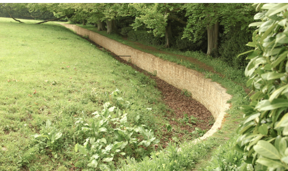
de tekening en foto tonen het principe van de Ha-ha wall
