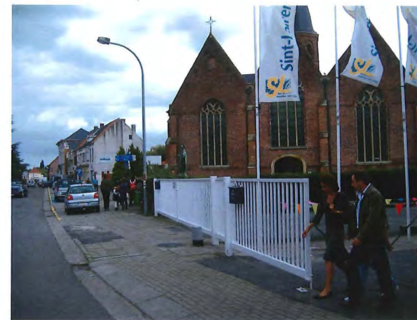
41. bestaande toestand: verborgen kerkgevel
