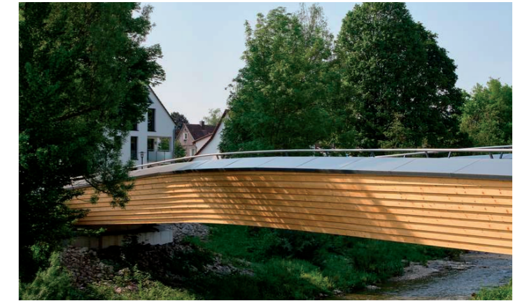
houten blok gelamineerde brug, Balingen Duitsland (Moxon)
