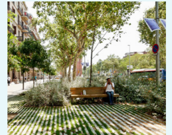
Referentie parkboulevard: waterdoorlaatbare en groene rustplekken op de 'Passeig Sant Joan' in Barcelona
