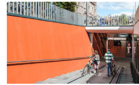
Fietsenstalling Station Haarlem trap met fietsgleuf
