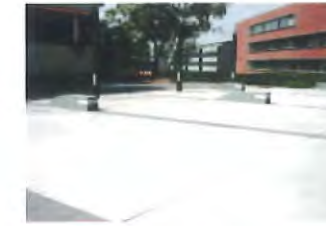
betonplaten voor binnenkoer
