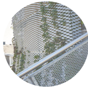
Het paviljoen bestaat uit een lichte metalen structuur, waarlangs vegetatie omhoog kan groeien.
