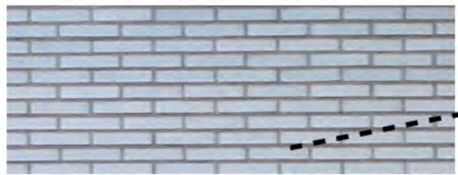
Bestaande baksteengevel blijft behouden
