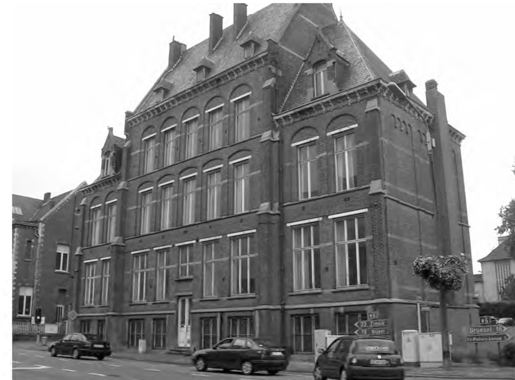
De ietwat monumentale voorzijde van het gebouw vergroot de toegansdrempel van het gebouw.
