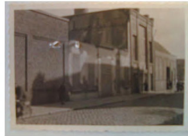
Buurgebouw van hoofdgebouw, zijde Vaartstraat Op de oude foto rechts het vroegere gebouw aan het Werfplein
